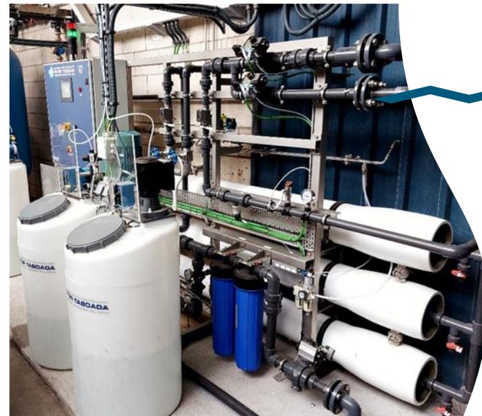
La depuración del agua industrial consiste en una ultrafiltración por medio del proceso de ósmosis inversa. En el proceso anterior, la EDARI (Estación Depuradora de Aguas Residuales Industriales) utilizaba tratamientos fisicoquímicos y biológicos, siendo la cantidad de agentes químicos utilizados y lodos generados, directamente proporcional a la carga contaminante del agua a depurar.
